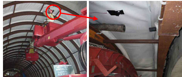
写真-7 施工状況
