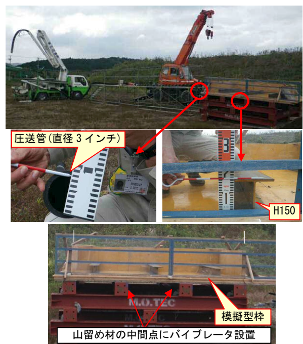
写真-3 全景, 圧送管 (直径 3 インチ) および模擬型枠
