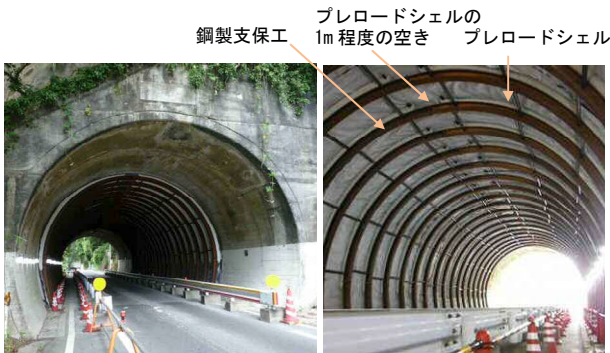
写真－1 施工前の坑内状況
