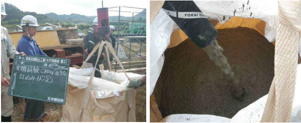
写真-4 圧送性確認状況
