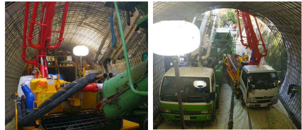
写真-6 天端部の配管設置状況
