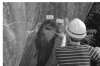
写真-7 内視鏡調査の様子 (ブロントサウルス)
