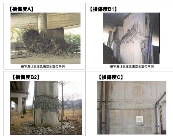
図-1 損傷度の判定区分の例
