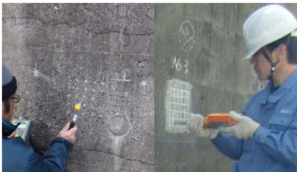
図-3 機械インピーダンス法（左、研磨前）と反発度法（右、研磨後）の測定状況
