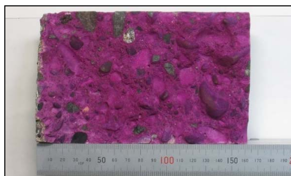
写真-7 中性化深さ試験結果(気中部)
