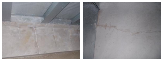
(d) 超速硬無収縮モルタル (e) 超速硬無収縮コンクリート
