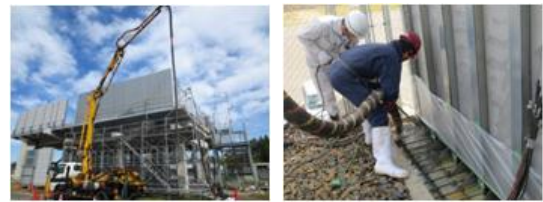
(a) 「普通コンクリート+膨張材」と「普通コンクリート+膨張材+繊維補強材」
