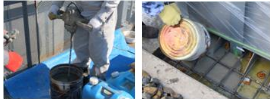
(b) 「無収縮モルタル+繊維補強材」
