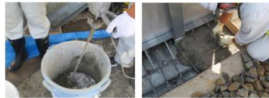
(c) 「高靱性繊維補強ポリマーモルタル」
