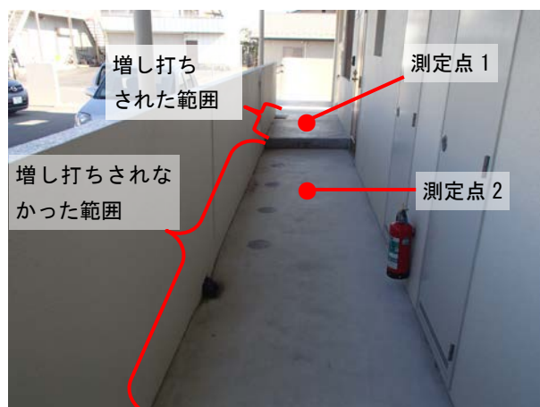
写真-4.1 二本松市のマンションにおける対応状況
