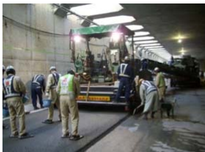
写真-3 アスファルトフィニッシャーによる敷均し
