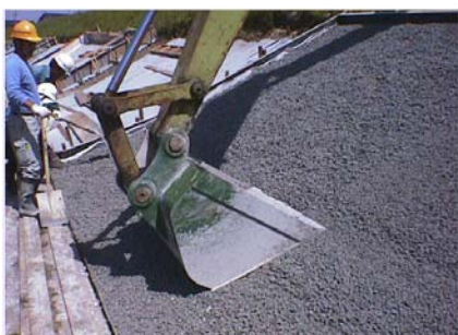
写真-2 バックホウによる護岸の締め固め
