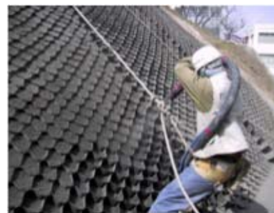
写真-4 吹付け工法による法面保護工(準乾式)
