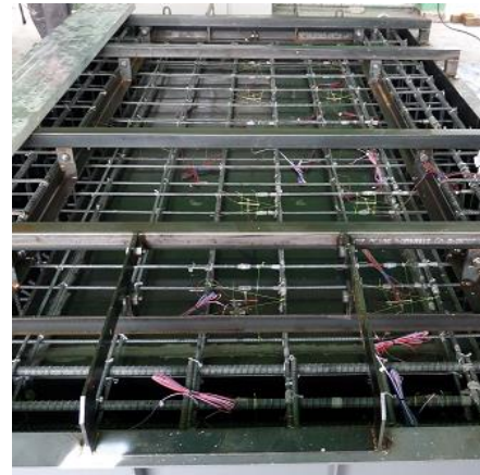
図-4 梁付スラブ配筋状況
