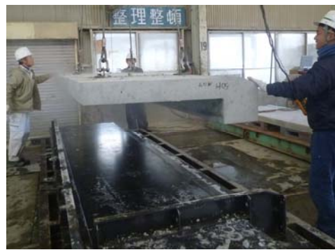
写真-1 実大部材の吊り上げ状況 (超速硬: W/B=50%)
