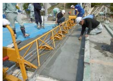
写真-3 試験施工実施状況
