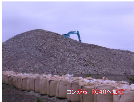
図-2 再生クラッシュランの保管状況 (仙台市内, 2012年3月)
