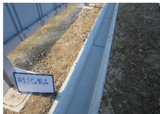
図-15 落蓋式U形側溝の設置状況
