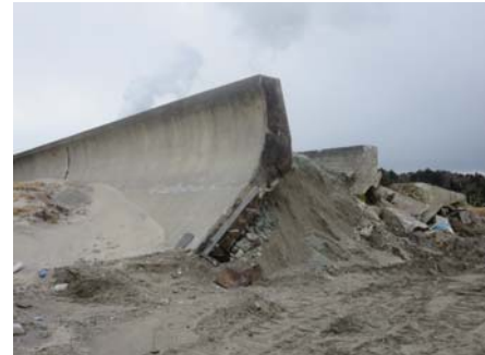
図-4 放置コンクリート塊の状況 (南相馬市内, 2014年12月)
