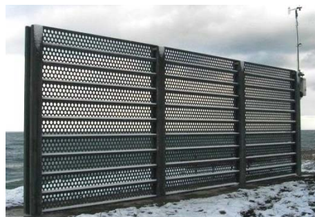
写真-6 設置した UFC 製防風柵
