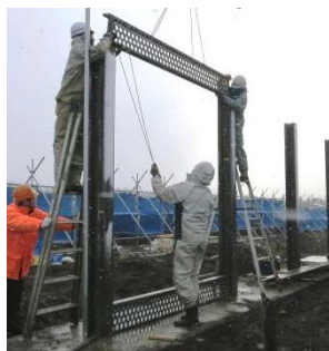
写真-5 UFC 製防風柵の設置状況
