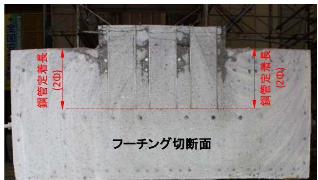
写真-3 鋼管定着部の状況 (フーチング切断面)
