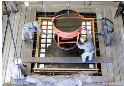
写真-1 UFC床版試験体の打設状況
