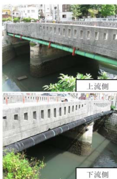
写真-1 対象橋梁の側面写真(撤去前)
