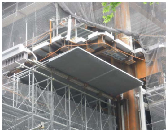
写真－5 庇の取付け状況
