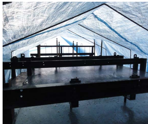
写真-2 底部材の養生状況
