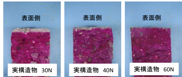
写真-1 実環境における防液堤コアの中性化状況
