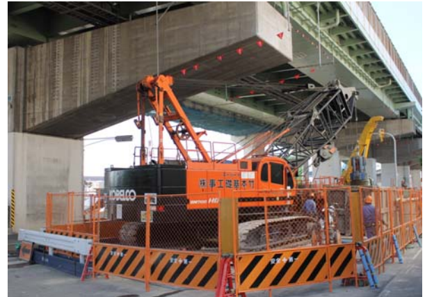
写真－2 低空頭用クレーンを用いた杭施工状況
