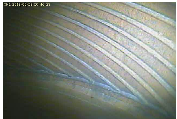
写真－4 水中カメラによる清掃状況(内面リブ目視確認)
