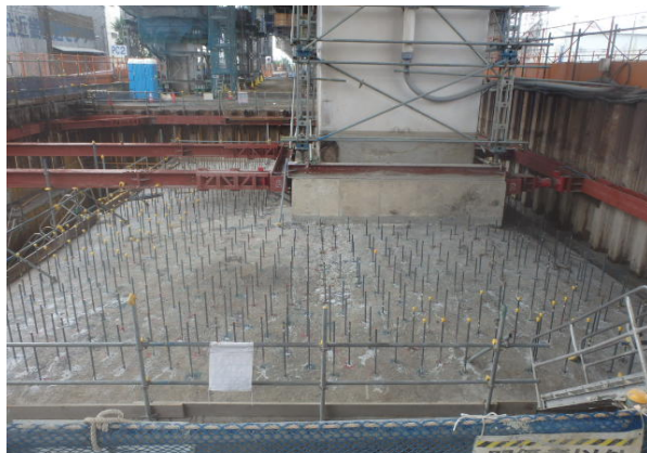
写真-7 既設フーチングのC C b 施工状況
