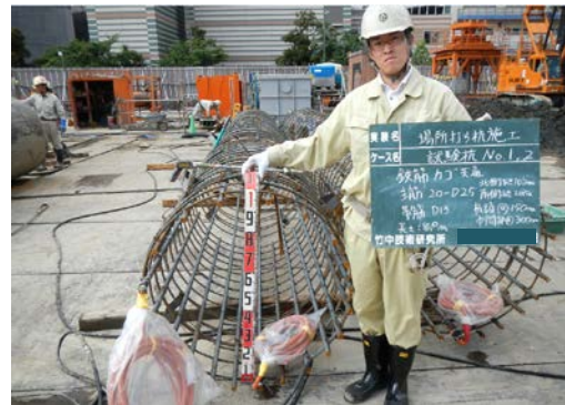
写真-1 鉄筋かごの寸法確認状況
