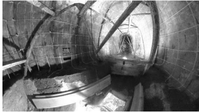
写真-4 鉄骨の状況 (ブロントサウルス)
