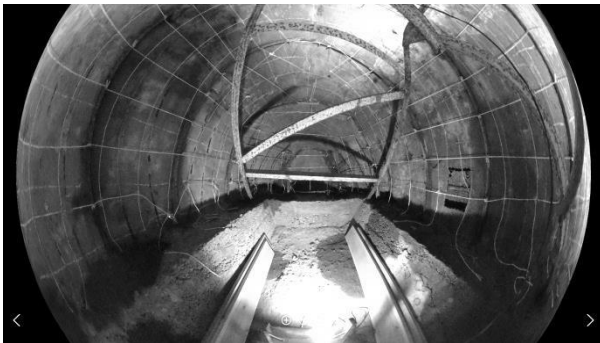
写真-13 全天球撮影(ブロントサウルス, 尻尾側半分)
