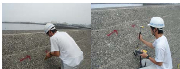
図-2 反発度法（左）と機械インピーダンス法（右）の測定状況
