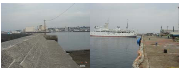
図-5 西山防波堤（左）、城ヶ崎 4 号係船岸壁（右）
