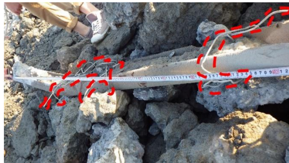
写真-7 堰柱内部の軌条
