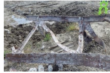
写真-4 内部鉄骨の状況
