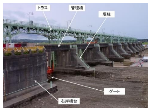
写真-1 旧可動堰全体写真
