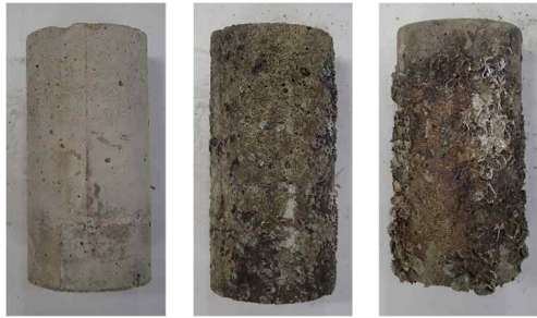
(a) 飛沫帯 (b) 干満帯 (c) 浸漬帯 写真-1 海洋環境暴露試験後の試験体の様子 (材齢910日)
