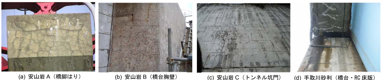
写真-1 反応性骨材と ASR 劣化構造物
