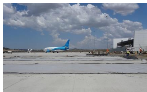
写真-6 施工後の状況
