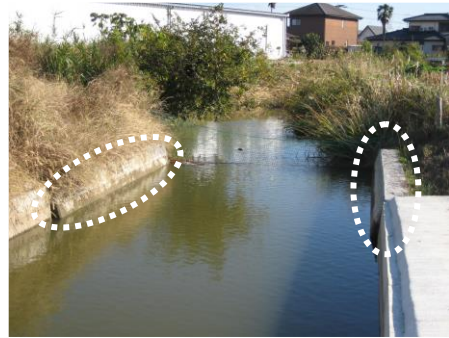
写真-2 施工後 7 年後の状況
