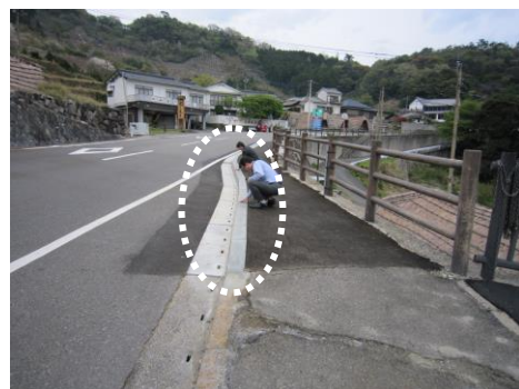
写真-4 施工後の状況
