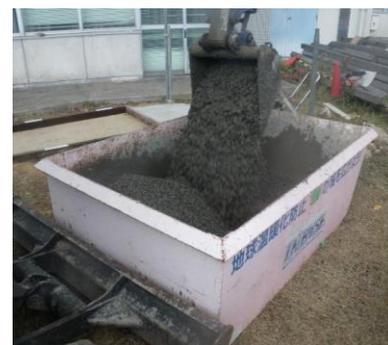
写真-3 油圧ショベルによる POC の練混ぜの様子
