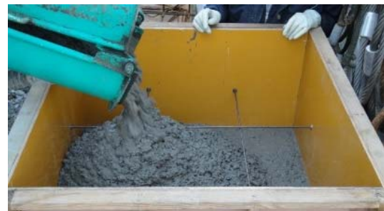
写真-2 型枠への打設状況
