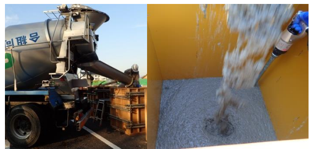
写真-2 柱試験体の打込み状況
