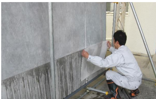
写真-3 養生シートの貼り付け状況
