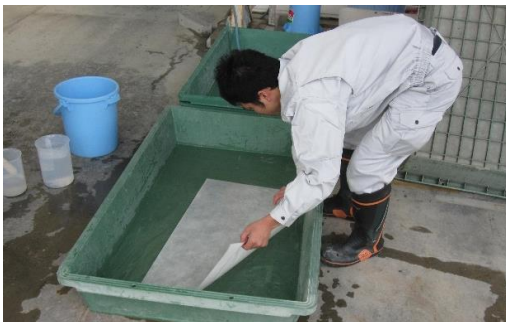
写真-2 養生シートの濡らし方の一例
