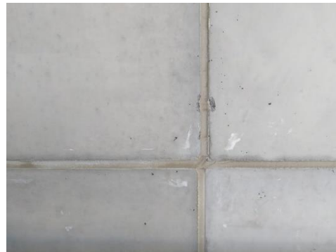
写真-1 シール目地部の例
