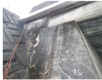
写真-3 ASR 判定橋梁
