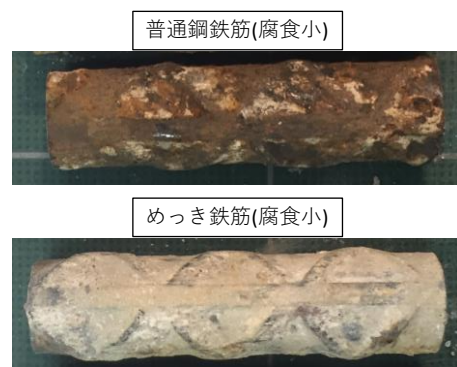
図-7 鉄筋の腐食性状 (腐食小)
