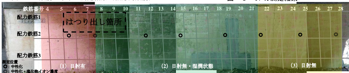
図-7 目視により得られる情報による区分設定とはつり出し箇所
