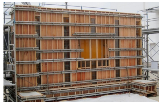
写真-1 実大試験体型枠状況
