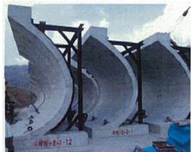
写真-1 フレア型護岸
