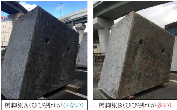
図-2 各橋脚梁の外観
