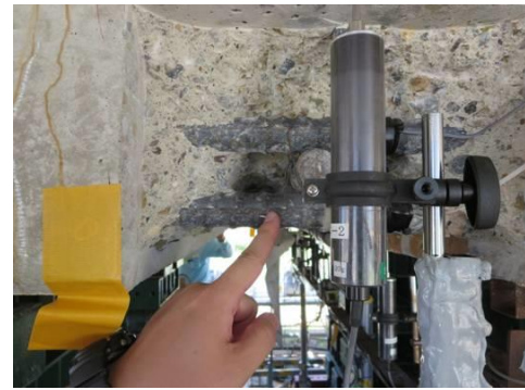
図-4 鉄筋はつり状況
