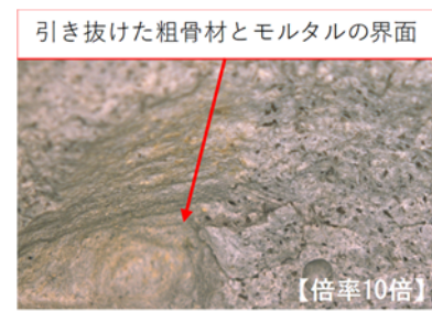
(d-3) 骨材の剥離跡
