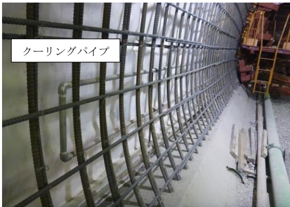
写真-1 クーリングパイプ設置状況
