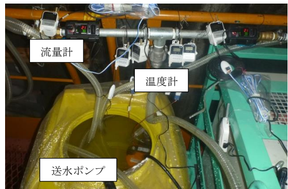
写真-4 送水設備設置状況 2
