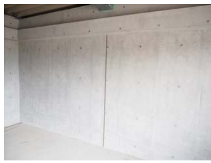
写真-6 壁部施工後の状況
