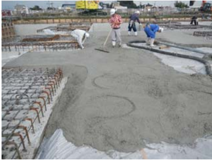
写真-2 レベルコン打設状況
