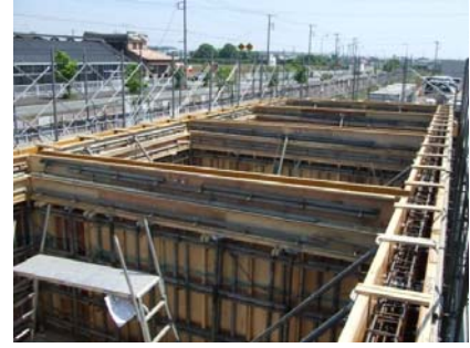
写真-4 壁部施工状況①
