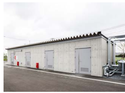
写真-7 付属舎棟施工後の外観
