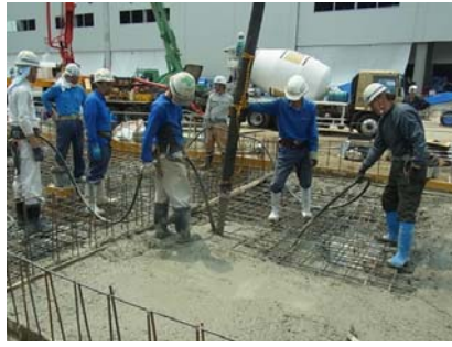
写真-3 基礎耐圧盤打設状況
