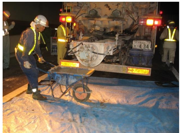
写真-2 一輪車を用いた SFRC の運搬
