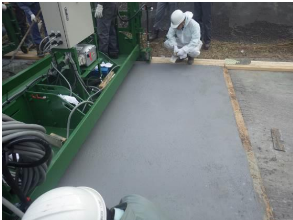
写真-4 新型フィニッシャーによる敷均し施工性試験
