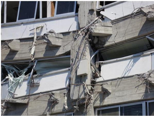
写真-2 外観（A<sub>2</sub>-B<sub>1</sub>）柱の4階部分の破壊状況
