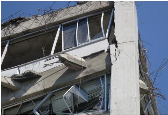
写真-3 外柱梁接合部の破壊状況
