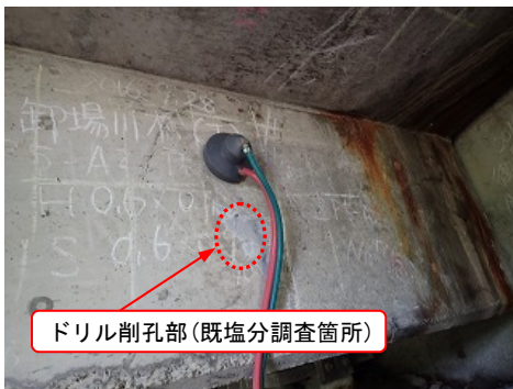
写真 - 5 表層透気係数測定状況 (O橋)
