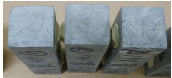
写真-2 促進膨張量試験後の状況 (反応性骨材・セメント単味)
