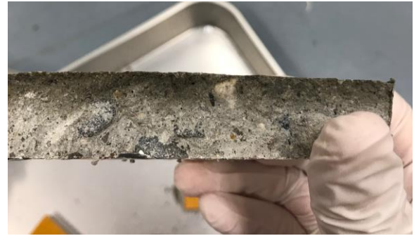
写真-1 浸透深さを示す濡れ色の例
