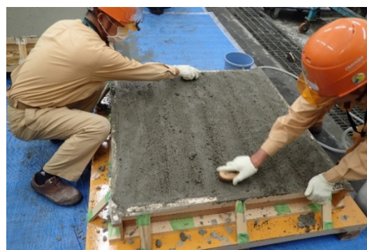
写真-2 レイタンス除去状況
