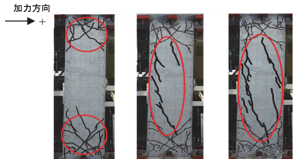
(a) せん断破壊前 (水平変形 2.85%) (b) せん断破壊後 (2.87%) (c) 崩壊時 (3.96%)
