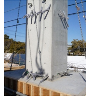
写真-4 PCaRC 柱の建込み
