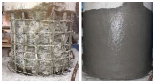
図-8 防錆処理後
